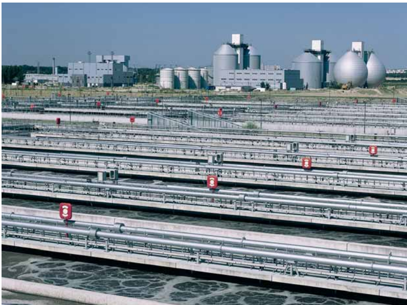
Abb. 7: Infrastruktureinrichtungen, wie zum Beispiel Kläranlagen, führen bei sinkenden Einwohnerzahlen zu höheren Wasserpreisen für die verbleibenden Nutzer.
